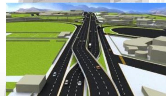
Distribuidor Vial Trenzado
